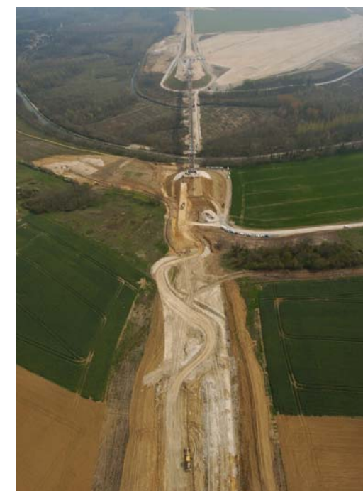
Les travaux de terrassement du franchissement de la vallée de l'Ourcq (Seine-et-Marne)
